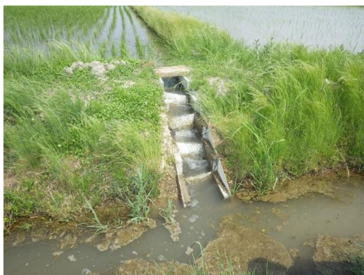
写真 志那中町で採用されている一筆方式の魚道
