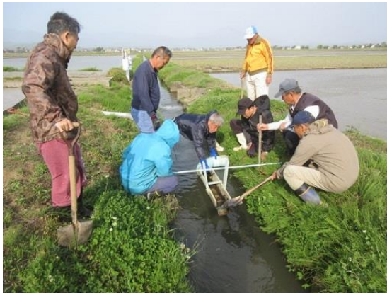
写真 一筆方式の魚道の設置
