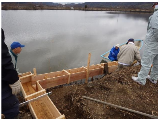
写真 魚道設置のようす（平成30年度）
